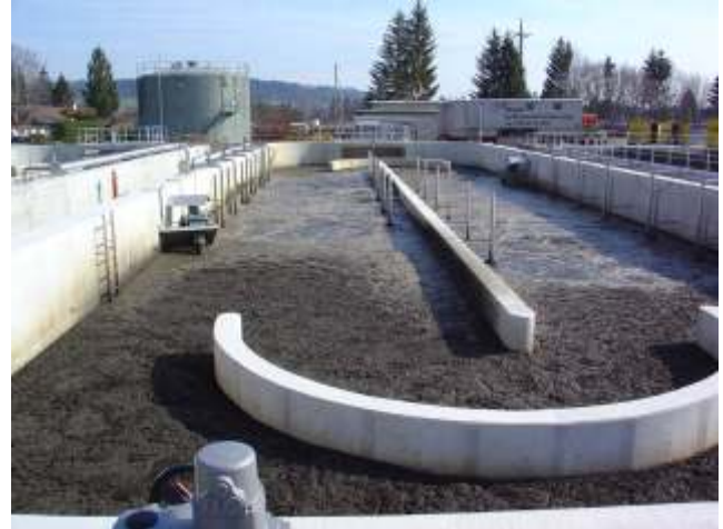
Abbildung: Belebungsbecken, Gasbehälter im Hintergrund links
