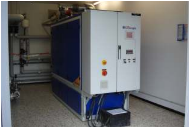
Abbildung: Blockheizkraftwerk
