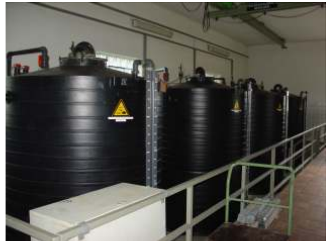
Abbildung: Fällmitteltanks
