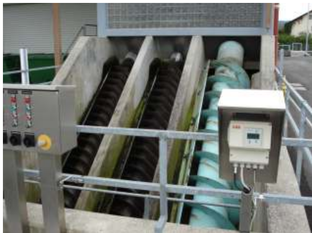
Abbildung: Zulauf-Hebewerk
