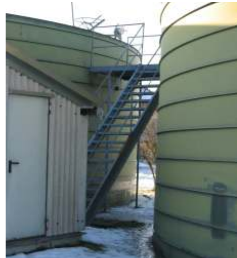
Abbildung: Schlammstapelbehälter
