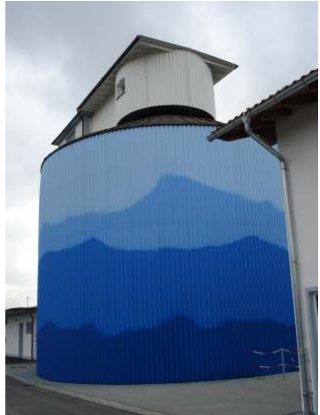
Abbildung: Faulbehälter
