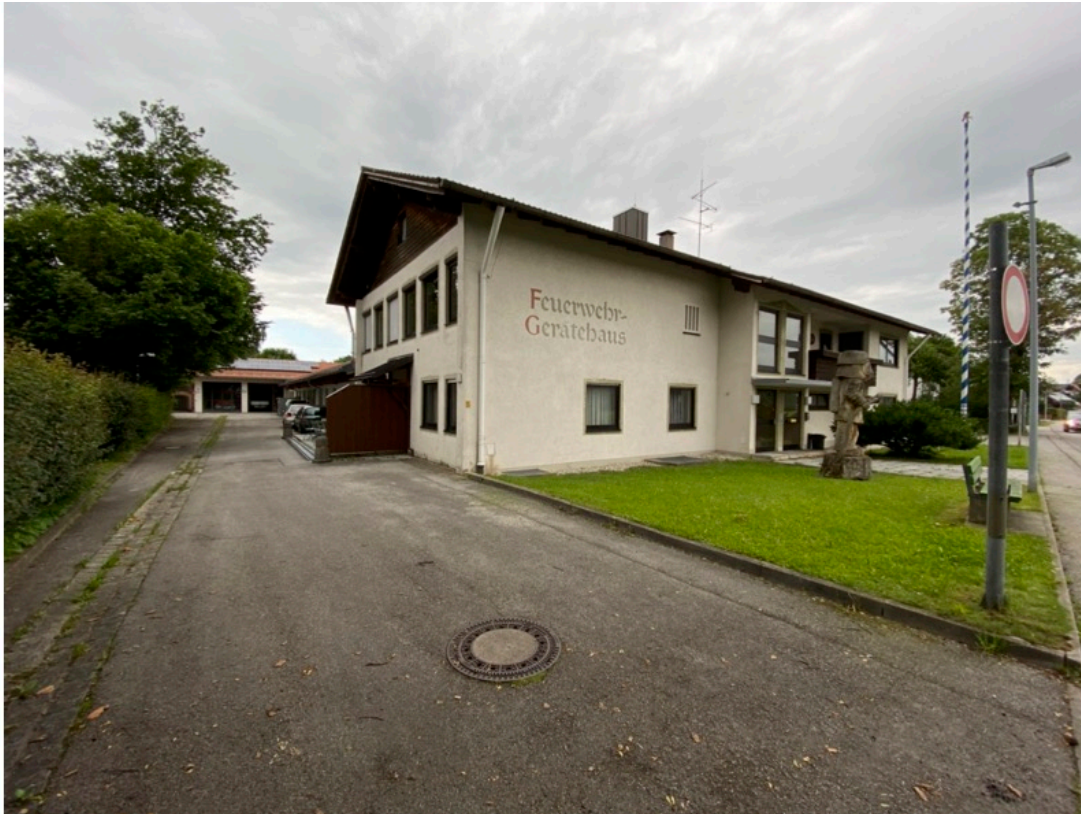
Abb. 3: Baubestand Quelle: B3 ARCHITEKTEN
