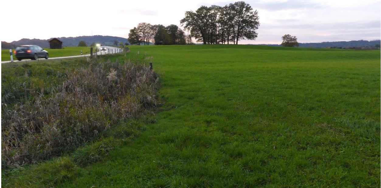
Abbildung 21: Blick von Osten nach Westen entlang der B472
