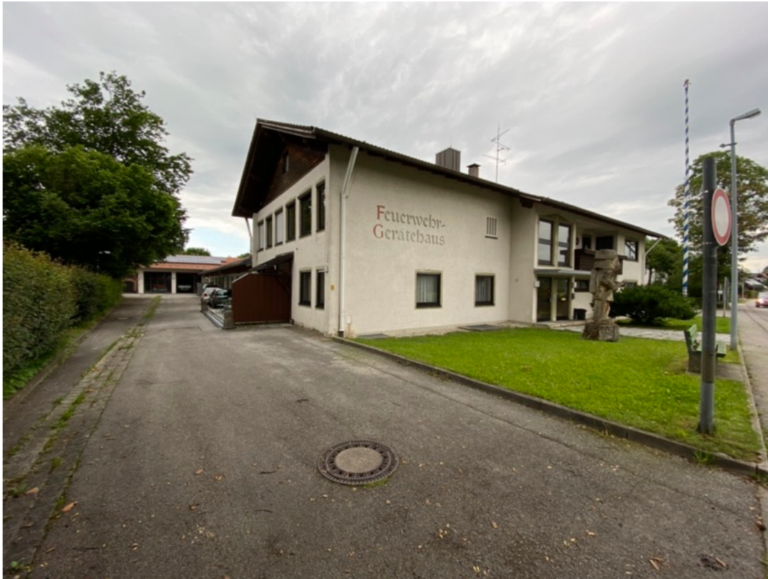
Abb. 3: Baubestand Quelle: B3 ARCHITEKTEN
