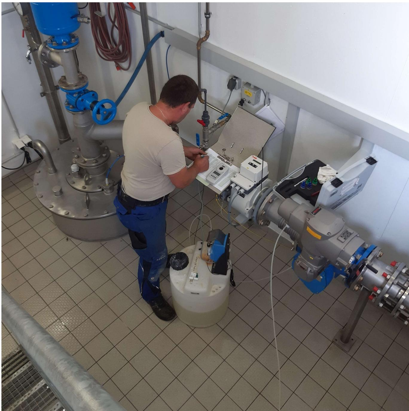
*Messung der Chlorkonzentration und Dokumentation der Messwerte durch Herrn Pössinger;
