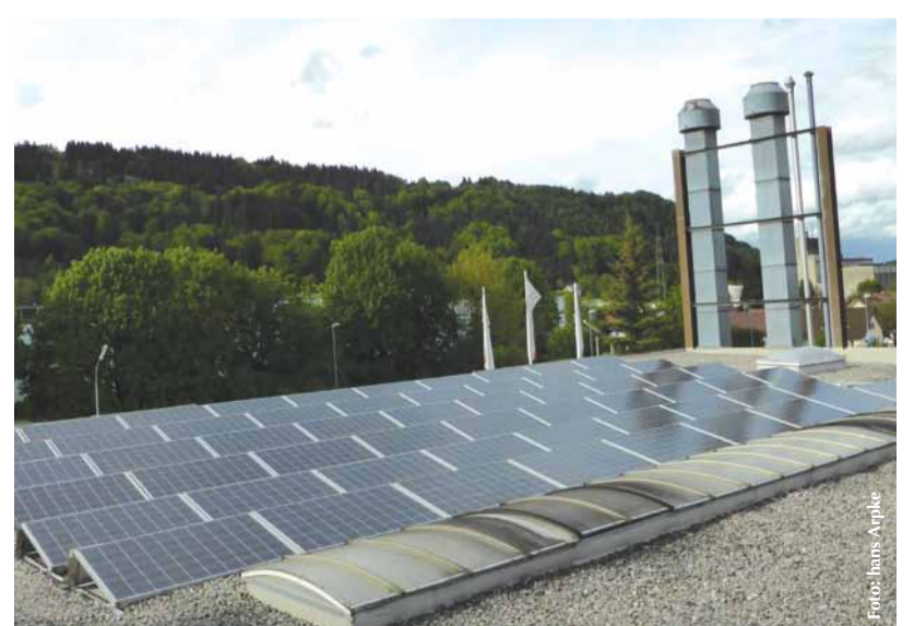
Auf dem Habersetzer Dach hat die Stromernte schon begonnen.
