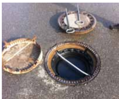
Schacht Nr. 451 mit neuem Schmutzfängereinsatz.
