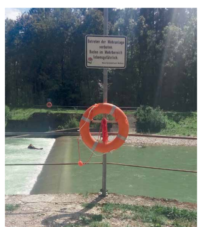
Zwei Rettungsringe jetzt am Wehr.
