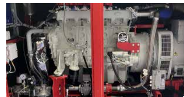
Bild 1: Blick über die drei Solaranlagen auf dem Kläranlagengelände Bild 2 und 3: Ansicht des BHKWs der Kläranlage Bild 4: Geplante Photovoltaikanlage auf der Friedhofslagerhalle
