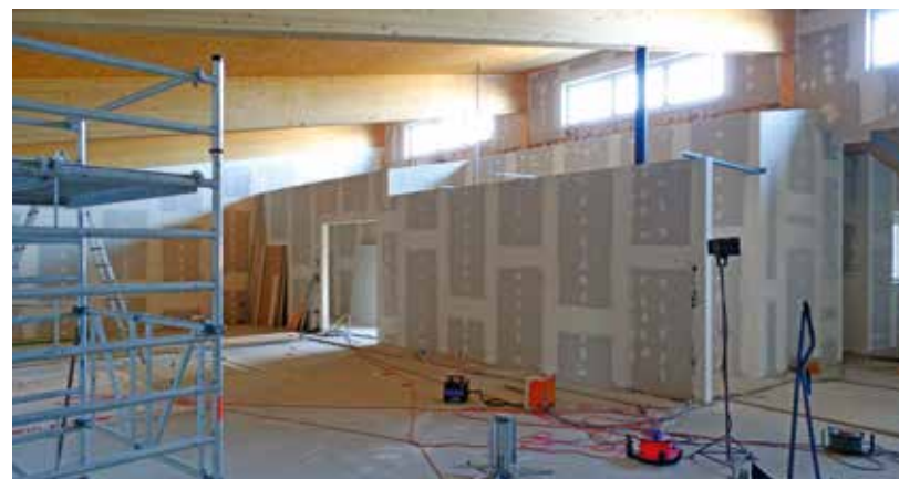
Umbau im Obergeschoss der Rigi Rutsch'n für das Therapiezentrum PRO.
